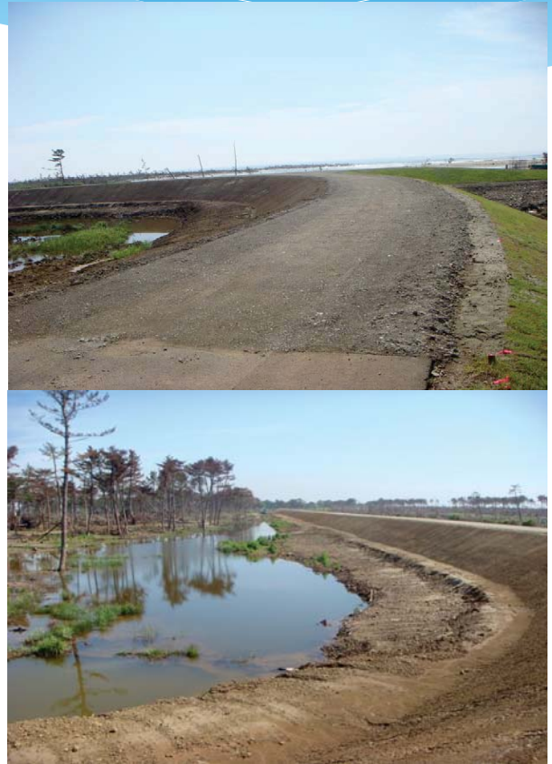
暫定復旧完了写真
