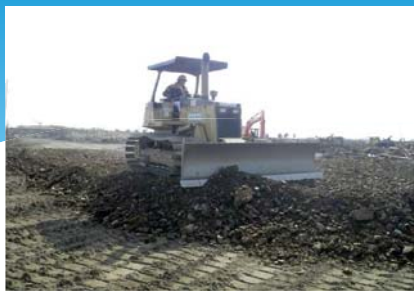
井土がれき搬入場造成隊 造成状況
