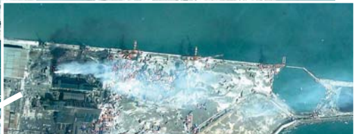
JFE条鋼仙台製造所：集積されていた鉄屑・鉄切削屑が津波により海水をかぶり急速に酸化が進んだが酸化熱が放散されずに蓄積されて出火したものと推定される
