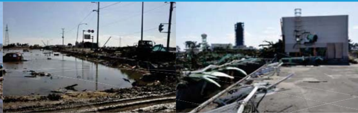
南蒲生地区道路状況
