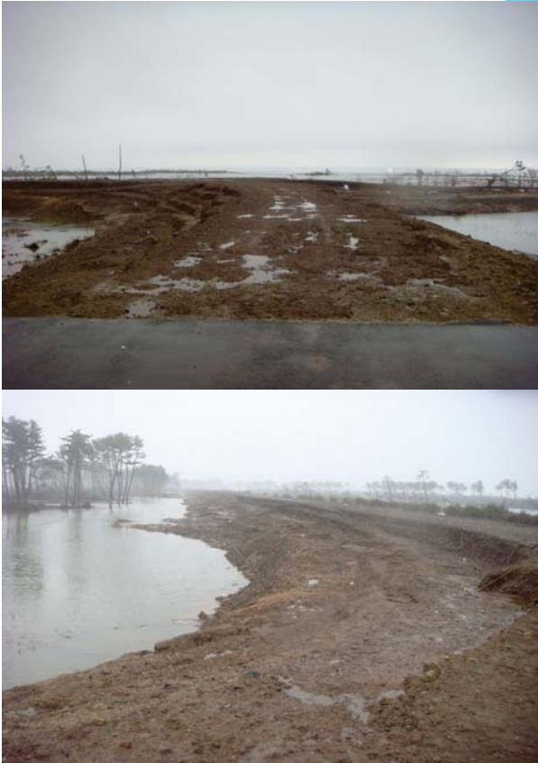
被災状況写真
