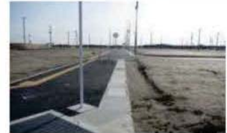
インフラ整備が進む六郷地区 (H27.3撮影)
