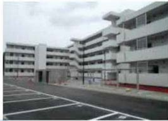
霊屋下第二 (H27.9月完成)
