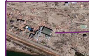
中野小学校：小学校の東側の住宅は全て流出した
