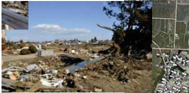
岡田地区住宅地周辺
