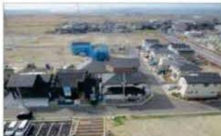
住宅建設が進む荒井東地区 (H26.11撮影)
