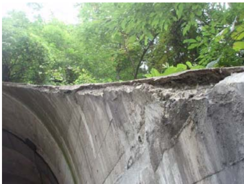
天端 縦断方向ひび割れ (ave. 0.48mm, 4.2m)
